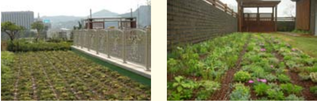
[그림6] 유니트형 옥상녹화 시스템 적용 현장
