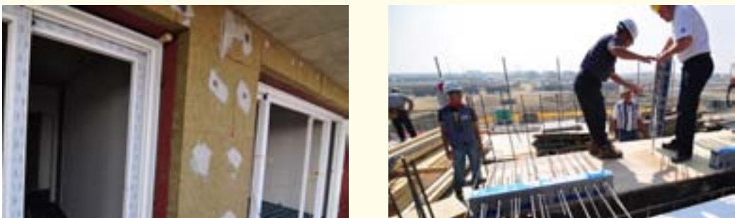
[그림3] 반건식 외단열시스템 및 열교차단부재 시공사례
