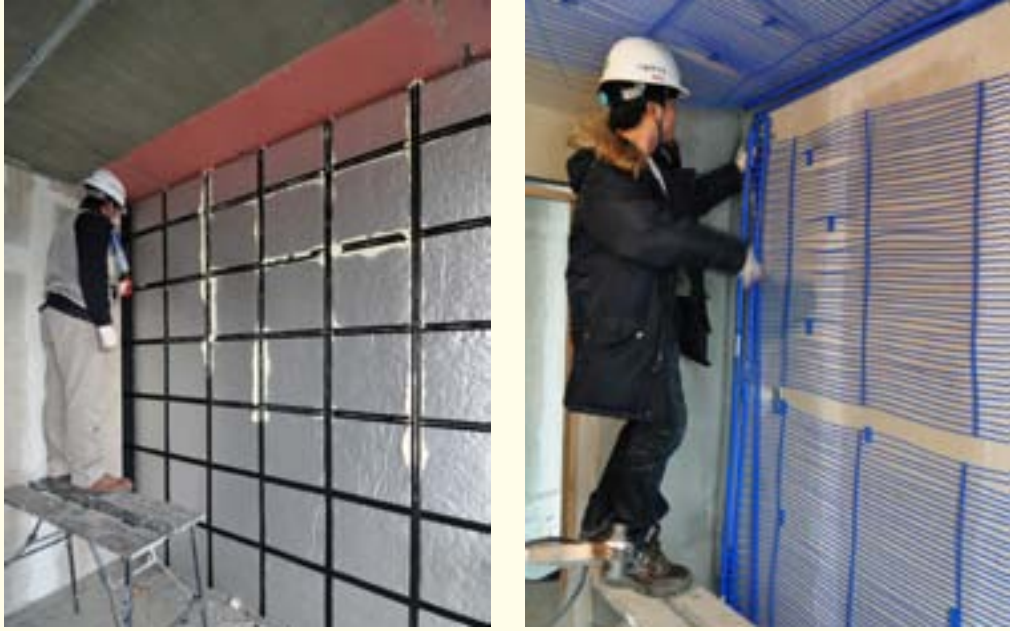
[그림4] 진공단열재 및 Capillary Tube 시공사례
