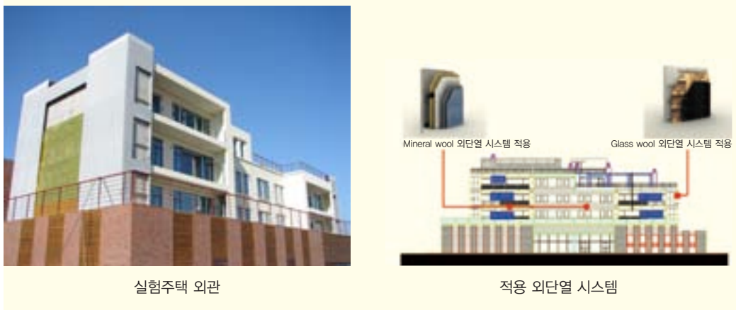
[그림3] 저에너지 친환경 실험주택의 외단열 시스템 적용
